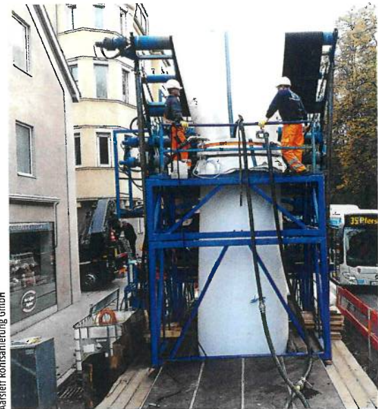
Aarsleff Rohrsanierung GmbH
