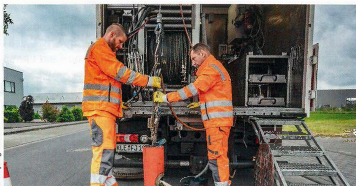
Nachdem die Fräsarbeiten durchgeführt wurden, kann der Janssen Process Stützenpacker für die Injektionsarbeiten eingebaut werden.
