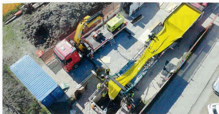
Impreg: In Italien wurde der weltweit erste CIPP-Liner GL16 DN 2000 WD 11mm (o. Peroxid), L 164 m, 22t Gewicht, eingebaut.
