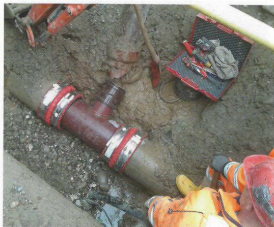
Bild 2: Mit dem Reparaturabzweig von Funke lassen sich schadhafte Kanäle aus Steinzeug oder Beton ausbessern und Hausanschlussleitungen nachträglich einbinden
