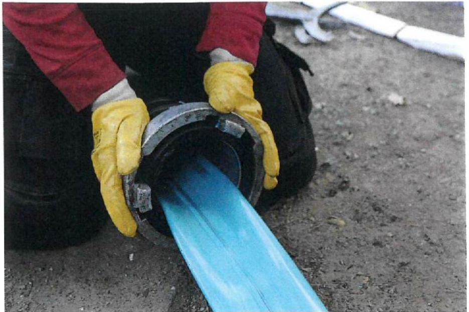
Das Schlauchlinerverfahren Mr. Pipe-Liner ist für alle Hausanschlussleitungen (Abwasser und Regenwasser) geeignet – u.a. bei Wurzeleinwüchsen, Scherbenbildung oder fehlenden Scherben, Rissen sowie verschobenen Verbindungen. Ergänzt wird das Verfahren durch den ebenfalls DIBT-zugelassenen Mr. Pipe-Stretch-Liner für die Sanierung von Leitungen mit drei verschiedenen Dimensionen/Nennweiten. | Foto: Canal-Control Rohrsanierung GmbH
