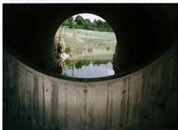
Eingebaute Wehranlage zum Drosseln, Kaskadieren und Spülen. © Uhrig Straßen- und Tiefbau GmbH
