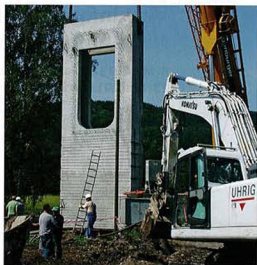
Wehrturm kurz vor dem Einbau in ein bestehendes Kanalnetz. © Uhrig Straßen- und Tiefbau GmbH
