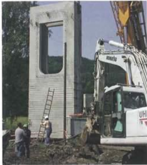
Bild 1: Wehrturm kurz vor dem Einbau in ein bestehendes Kanalnetz (Quelle: Uhrig Straßen- und Tiefbau GmbH)
