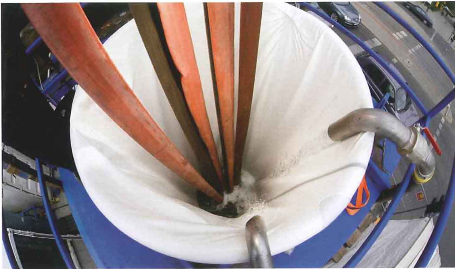
Inversion des flexiblen Schlauchliners, der sich unter konstanter Druckbeaufschlagung formschlüssig an das Altrohr anlegt und anschließend mittels der klassischen Warmhärtemethode kontrolliert aushärtet. | Foto: Insituform
