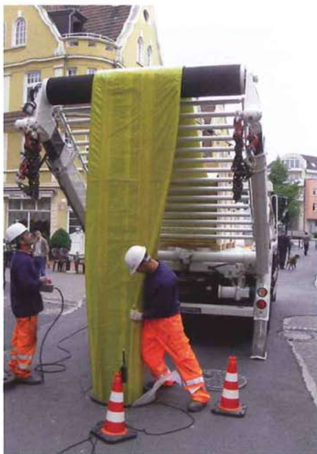
Eine sichere, schnelle und kostengünstige Sanierungsmethode: Der UV-härtende Glasfaserliner kommt verlegefertig auf die Baustelle. | Foto: Insituform
