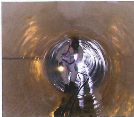
Das Ergebnis einer Schlauchlinersanierung ist ein naht- und muffenloses, formschlüssiges „Rohr im Rohr“, das einem neu verlegten Rohr in punkto Qualität in keiner Weise nachsteht. | Foto: Insituform
