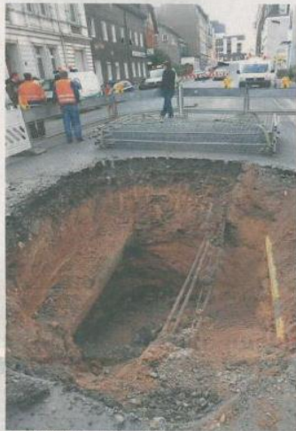
Etwa fünfeinhalb Meter ist das Loch in der Gasstraße an seiner tiefsten Stelle. Am Freitag hatten es die Entsorgungsbetriebe komplett freigelegt und die dort liegenden Leitungen überprüft. Jetzt ist es abgedeckt. – FOTO: KIMMEL
