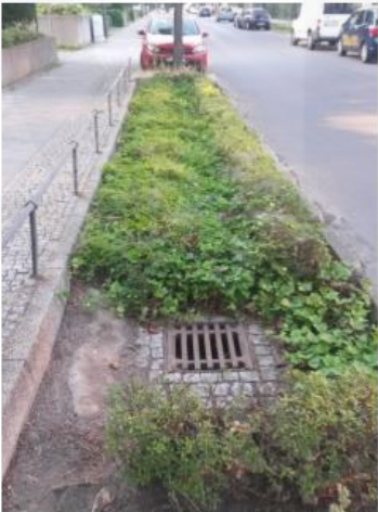
Abbildungen 79 & 80: Notüberläufe mit ordnungsgemäßen Abstand zur Muldensohle. Ausführung als Gitterrost (links) und als Überlaufrohr mit Tauchwandaufsatz (rechts)
