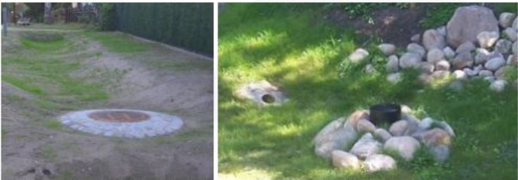
Abbildungen 79 & 80: Notüberläufe mit ordnungsgemäßen Abstand zur Muldensohle. Ausführung als Gitterrost (links) und als Überlaufrohr mit Tauchwandaufsatz (rechts)
