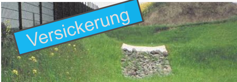
Mulden-Rigolenversickerung/ Mulden-Rigolen-System
