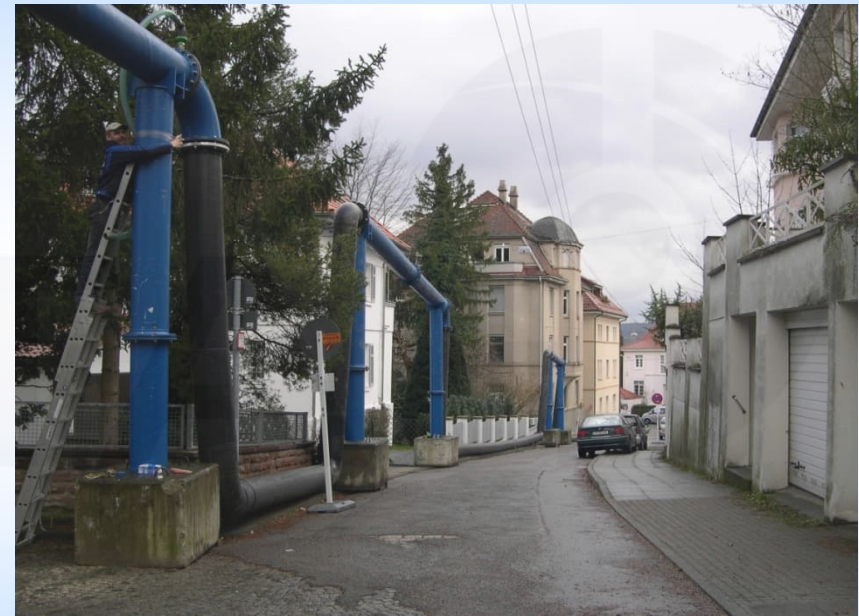
Rohrbrücken für die Abwasserüberleitung
