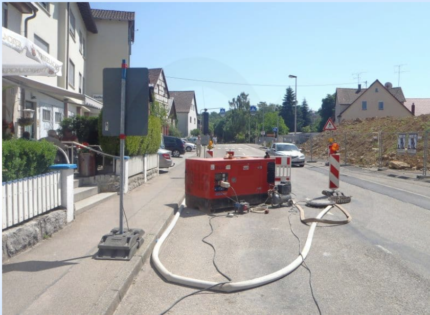
Abflussüberleitung oberhalb der Erneuerungsstrecke
