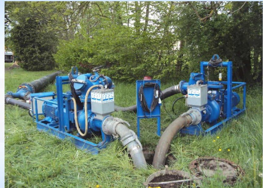
Abflussüberleitung mit Redundanz für rd. 200 l/s
