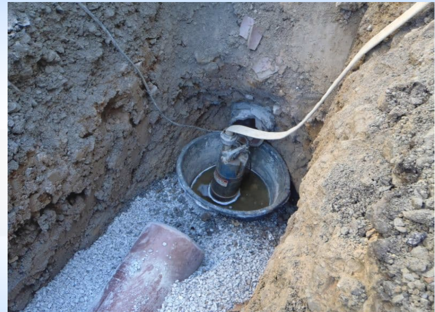
Abwasserüberleitung innerhalb Kanalgraben (für die Anschlüsse)
