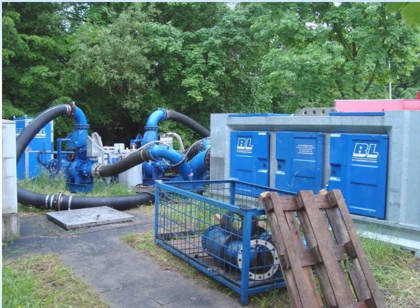
Abflussüberleitung mit Redundanz für rd. 500 l/s
