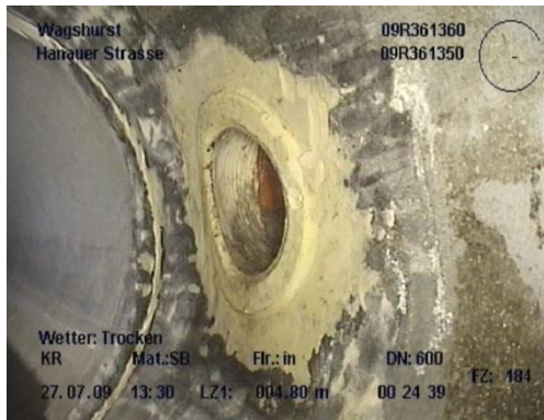
Bild 6: Erfolgreiche Sanierung mit Janßen Process Stützsanierung gegen Grundwasser
