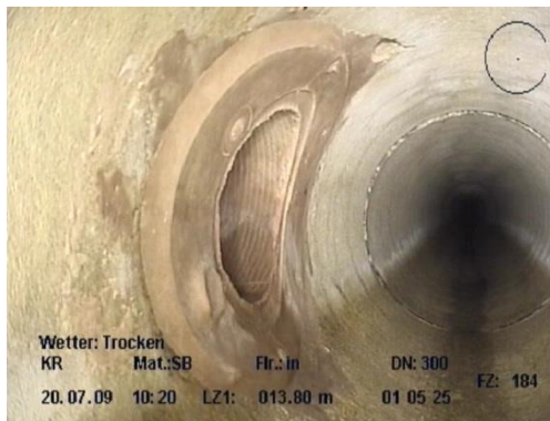
Bild 7: Erfolgreiche Sanierung mit Hächler EL 300/600
