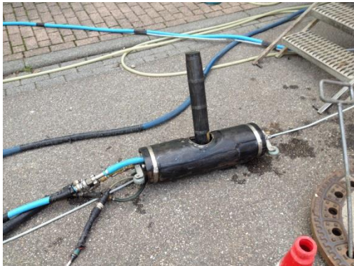
Bild 1: Injektion mit Mörtel (Strobel-Packer)
