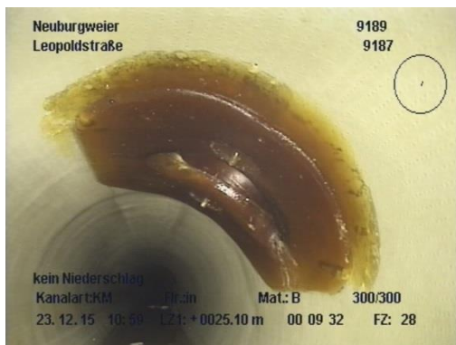
Bild 8: Erfolgreiche Zulaufeinbindung an Liner mit KASRO-2K
