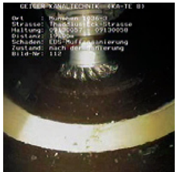
Bild 10: mittels Verspachtelung sanierte Rohrverbindung
