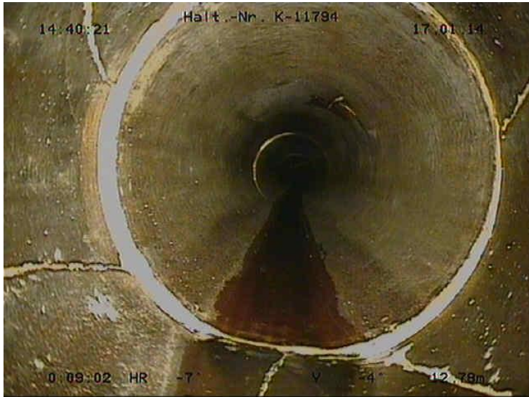
Bild 2: mittels Injektionsverfahren sanierte Rissbildung
