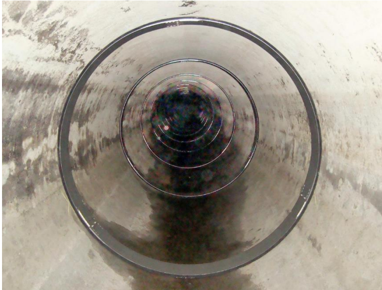
Bild 4: mittels Edelstahlmanschetten sanierte Rohrverbindungen (Quelle: Fa. Uhrig)
