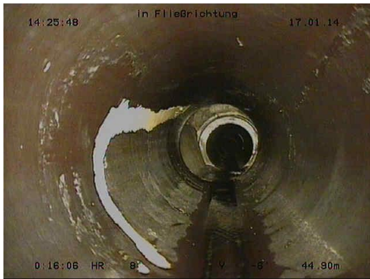
Bild 7: mit Spachtelroboter sanierter Riss
